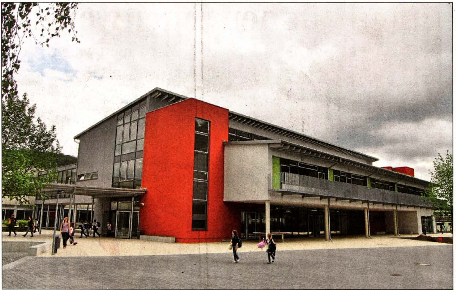
Nagelneu: Die Baustelle an der WvO ist Vergangenheit, morgen feiert die Schule ihr neues Gebäude.
